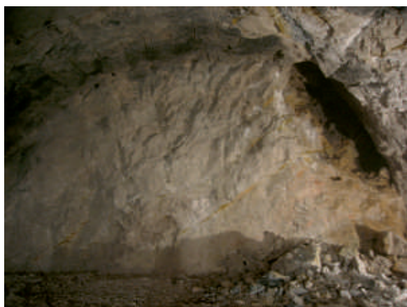
Cavidad kárstica detectada en el túnel de avance.
